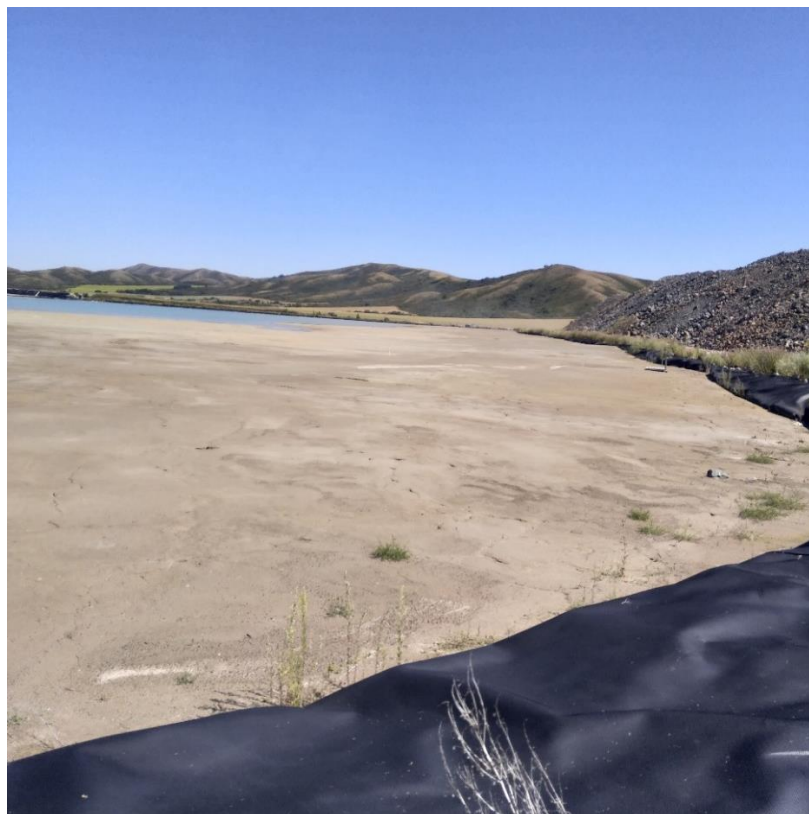
Рисунок 1 - Секисовское хвостохранилище: гидроизоляционная пленка
