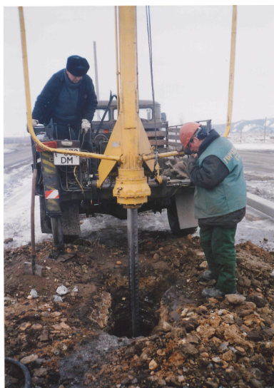
Рисунок 2 - Бурение исследуемых участков дорожного полотна буром УГБ 50 М
