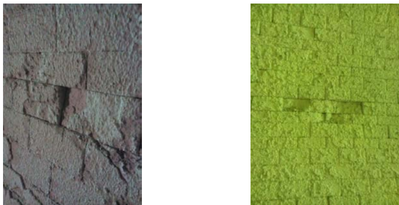
Рисунок 4 – Состояние футеровки зоны прокали
