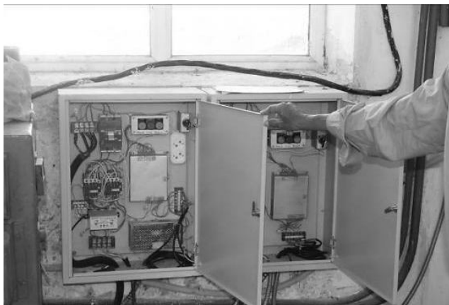
Рисунок 4 – Щит управления затворами
