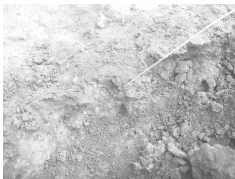
Рисунок 3 – Конструкция дорожной одежды на км 307: а - нижний слой а/б покрытия, поперечная трещина ярко выражена; б - верхний слой основания, трещины отсутствуют; в - нижний слой основания, трещины отсутствуют
