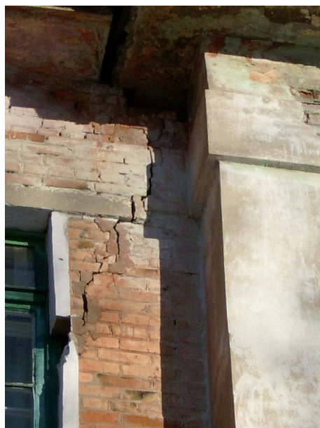
Рисунок 1 – Трещины в наружных стенах здания школы № 5
