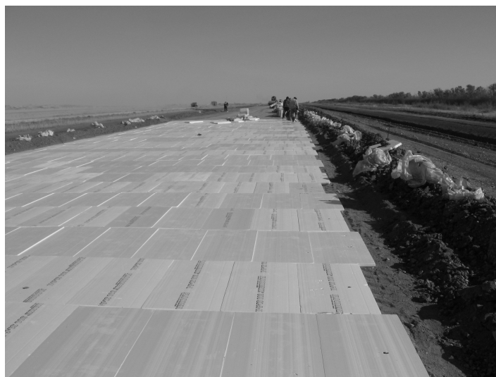
Рисунок 2 – Технологический процесс укладки материала Styrofoam в нижнем слое дорожной одежды
