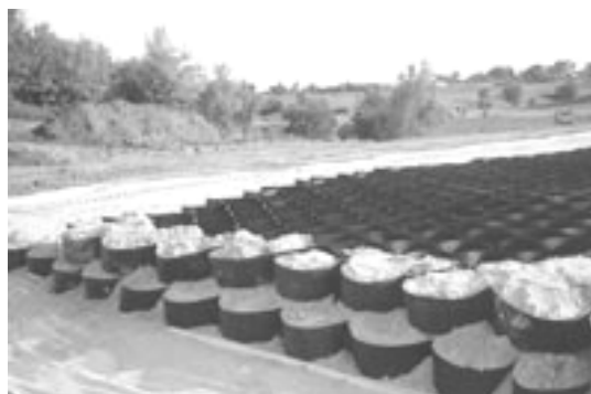
Рисунок 6 – Внешний вид и установка геотехнических решеток
