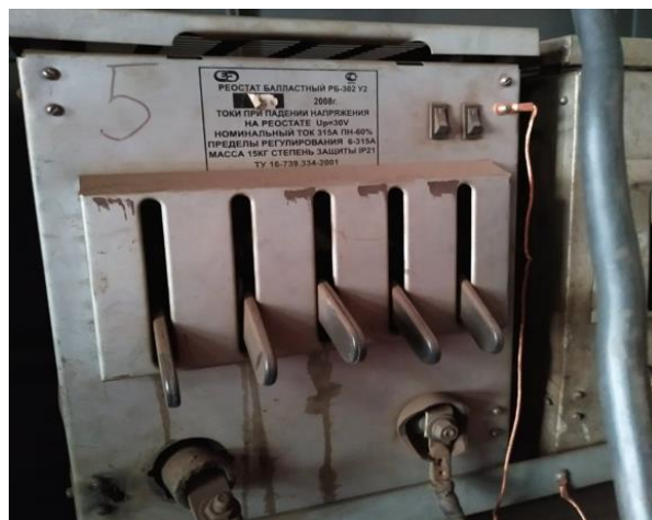
Рисунок 2 – Балластный реостат РБ-302 У2
