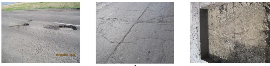
Рисунок 2 – Типы дефектов и разрушений дорожной одежды: а – выбоины и колейность; б – сетка трещин; в – отраженные трещины
