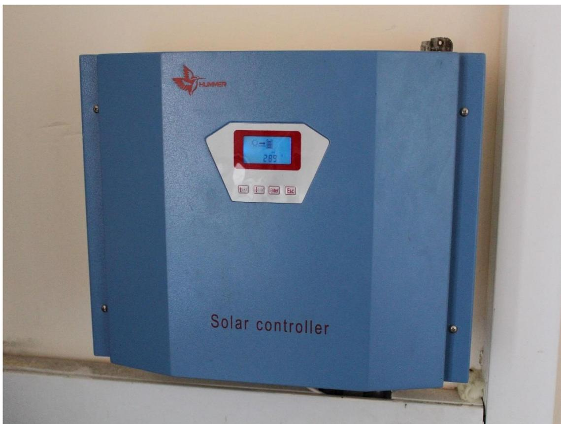
Рисунок 3.14 – Контроллер солнечных панелей
