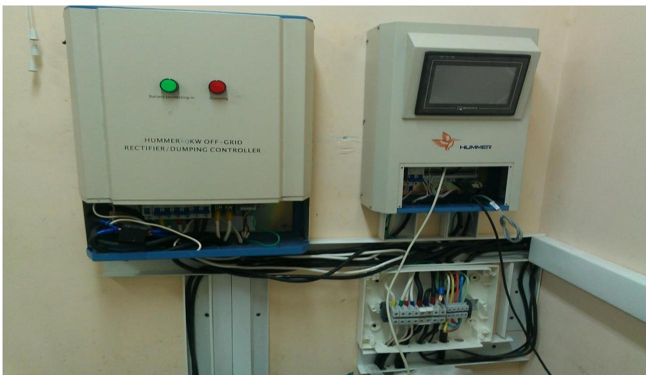
Рисунок 3.15 – Модуль управления ветрогенератора, выпрямитель и контроллер ветрогенератора
