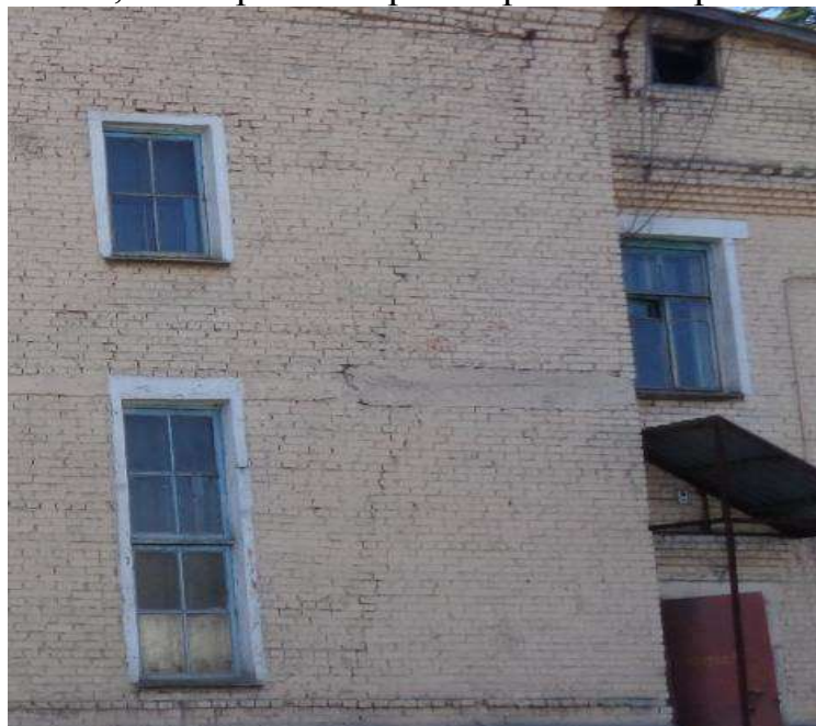
Рисунок 2 – Высолы, выветривание раствора швов кирпичной кладки
