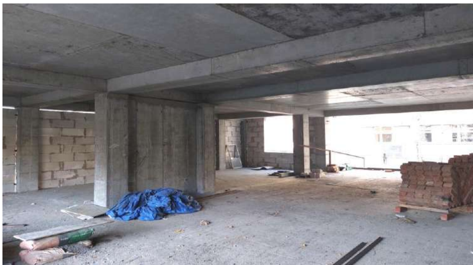
Рисунок 3 – Фрагмент каркаса здания
