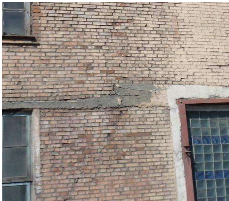
Рисунок 2 – Высолы, выветривание раствора швов кирпичной кладки
