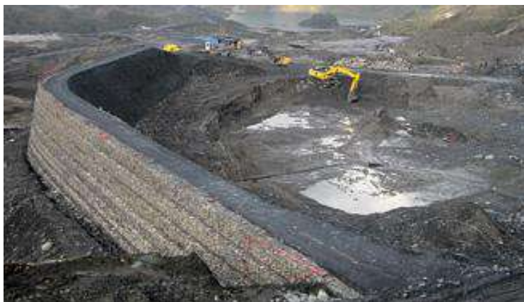
Рисунок 3 – Внешний вид ограждающей дамбы, выполненной из вертикальных технотуб
