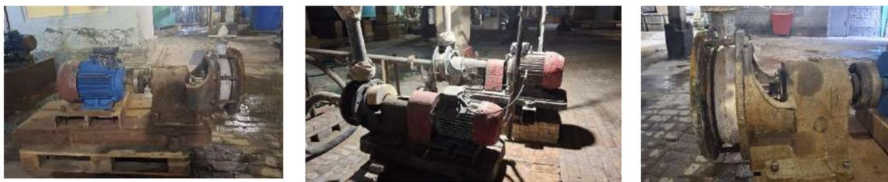
Рисунок 1 – Горизонтальные шламовые насосы модели КНЗ 6/30 и КНЗ 8/32 используемые в ТОО «Казцинк»
