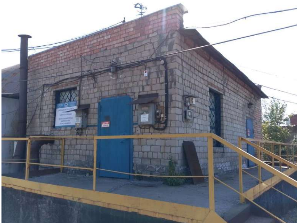
Рисунок 1. Общий вид склада баллонов с аммиаком
