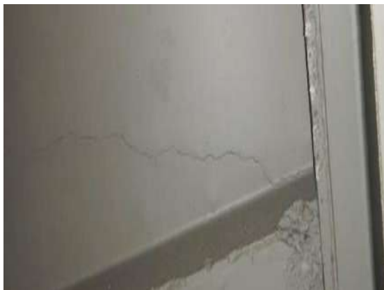
Рисунок 1. Трещины в железобетонных элементах
