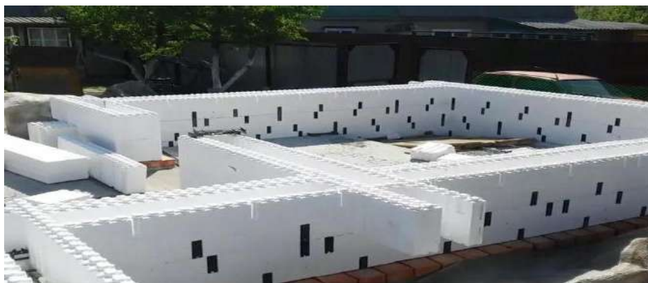
Рисунок 1. Полистирольная несъемная опалубка
