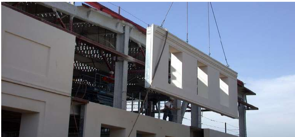
Рисунок 4. Несъёмная опалубка из объёмных армоблоков СФБО
