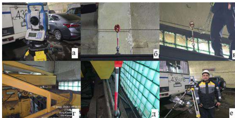
Рисунок 1. Фотофиксация процесса геодезического контроля планово-высотного положения подкранового пути:
