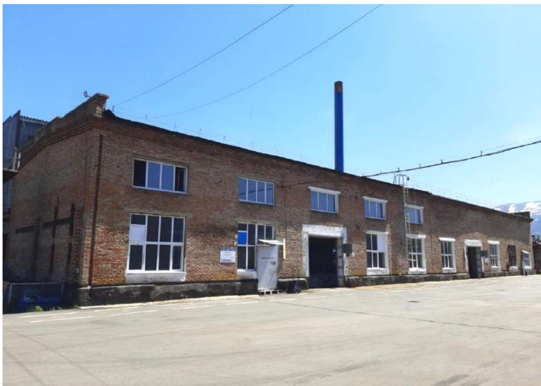
Рисунок 1 – Общий вид здания моторного отделения
