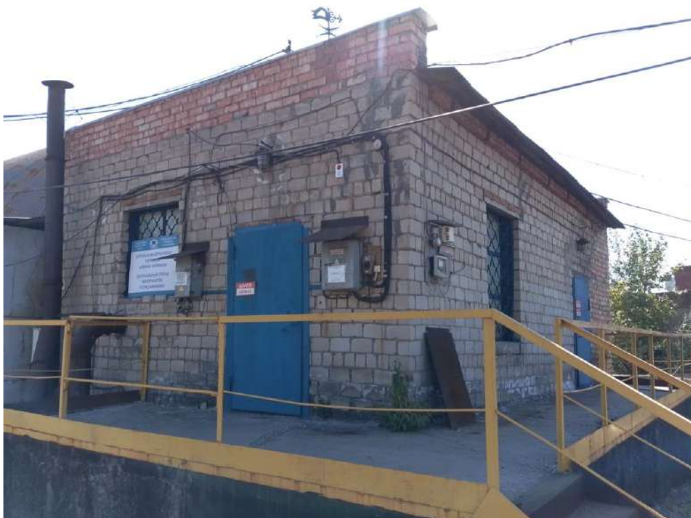
Рисунок 1. Общий вид склада баллонов с аммиаком
