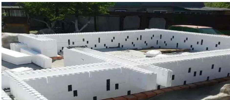
Рисунок 1. Полистирольная несъемная опалубка
