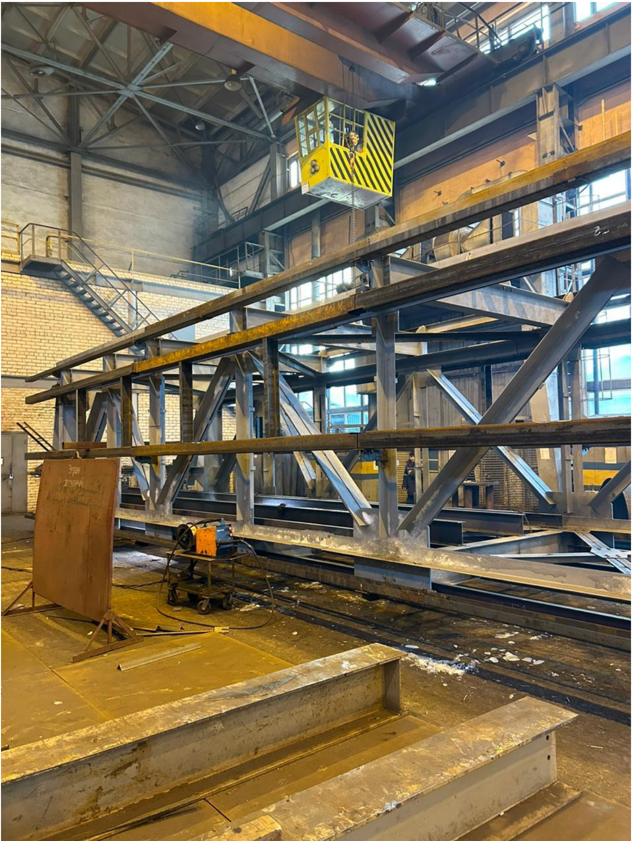
Рисунок 3 - Сборка металлоконструкций на сборочном заводе
