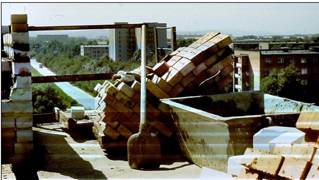
Рисунок 2 – Размещение материалов при строительстве жилого дома.
