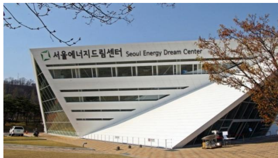
Рисунок 2 – Здание Seoul Energy Dream Center [7]
