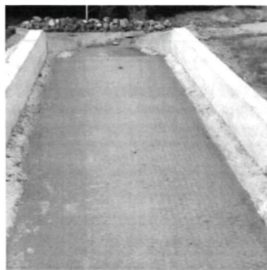
Рисунок 1.12 – Ливнеспуск на улице Запад-
