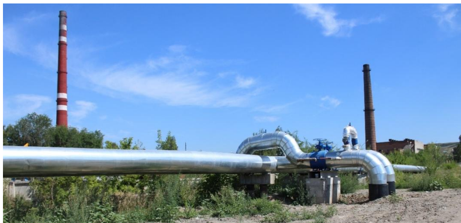
Рисунок 1 - Котельная № 2 г. Усть-Каменогорск
