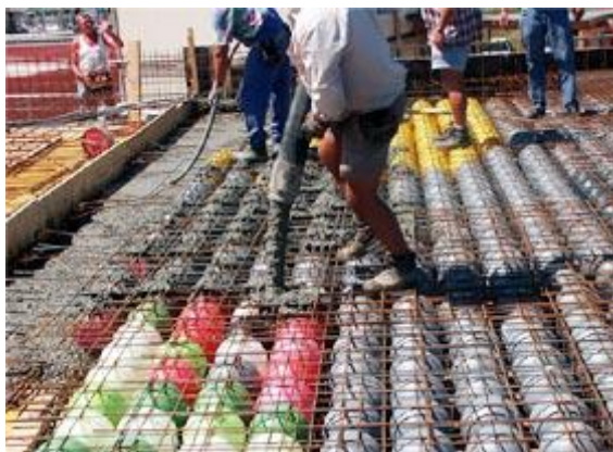
Рисунок 3 – Бетонирование перекрытия
