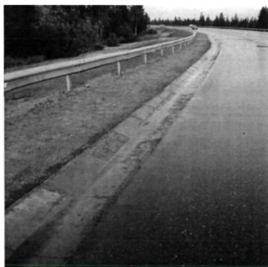
Рисунок 1.11 – Поверхностный лотковый во-
