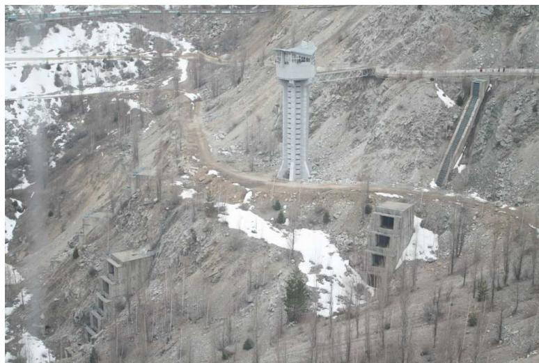
Рисунок 1 Селезащитная плотина Медео и водосбросные сооружения
