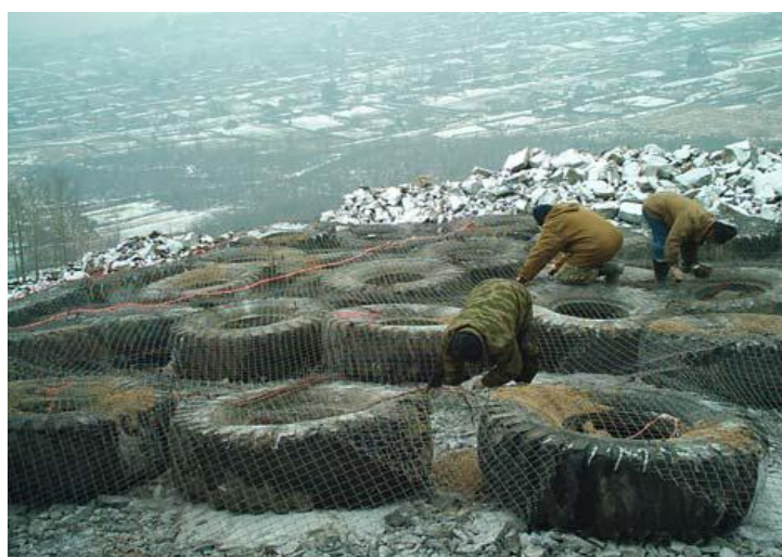
Рисунок 2 – Монтаж укрытия с сеткой «Рабица»
