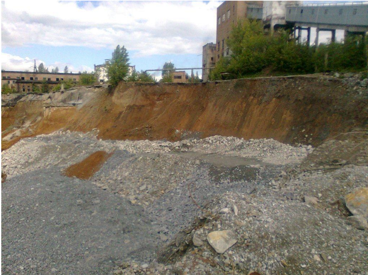
Рисунок 4 – Контрфорс, созданный у основания перегрузочного пункта
