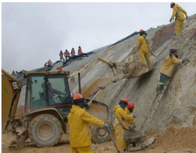
Рисунок 2 – Подготовка поверхности перед установкой геосинтетических глинистых экранов и геомембран [7]
