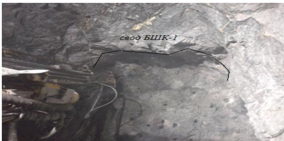
Рисунок 1 – Вид кровли БШК-1 при взрывании забоя обычным способом (отмечено интенсивное заколообразование)
