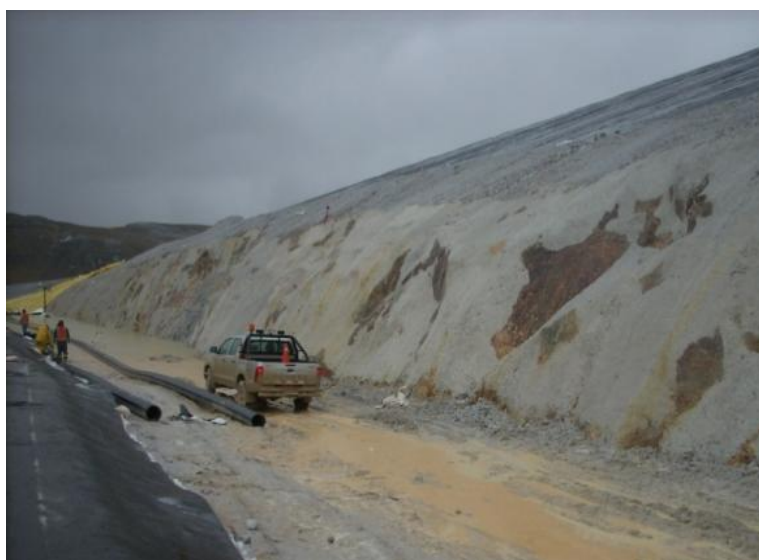
Рисунок 3 – Подготовленная скальная поверхность, до установки геосинтетических глинистых экранов или геомембран [7]
