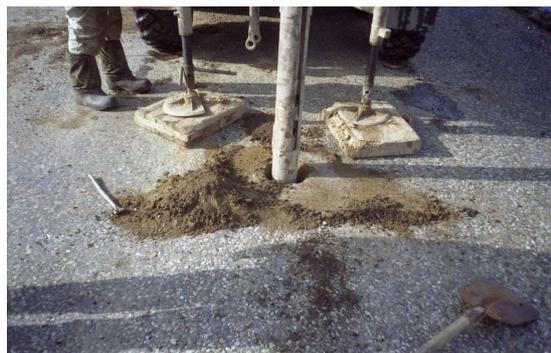
Рисунок 3 - Машина УГБ 50М в процессе
