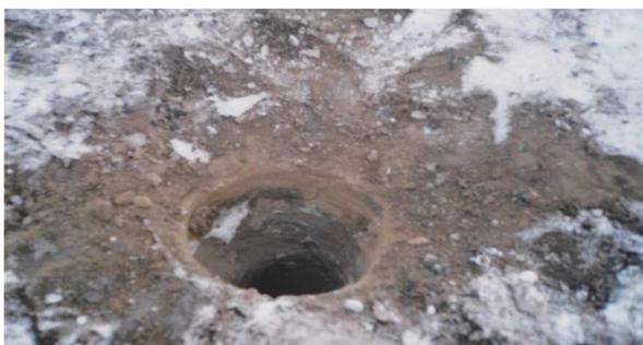
Рисунок 11 - Пробуренная дорожная конструкция, глубина 4 м
