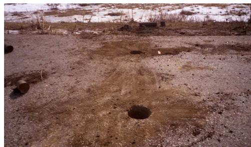
Рисунок 10 - Пробуренная дорожная конструкция посередине проезжей части, посередине полосы движения
